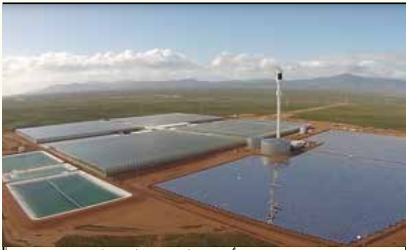
صحراء جنوب أستراليا (توليد الكهرباء وزراعة الخضار)
